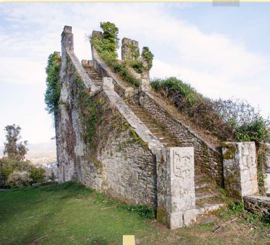
Torre de la Fortaleza
