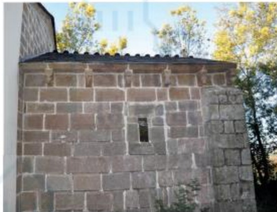
Vista del frontón sur del ábside
